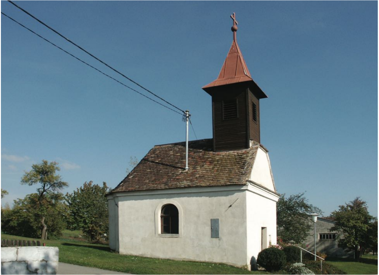
Bild oben: Ansicht West
